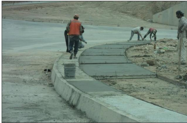
3. – SEPTIEMBRE: Construcción de firme de concreto de 10 cm en grieta.
