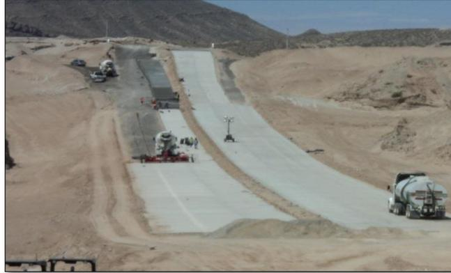
1. - JULIO: Construcción de losa de concreto hidráulico de 28 cm de espesor.
