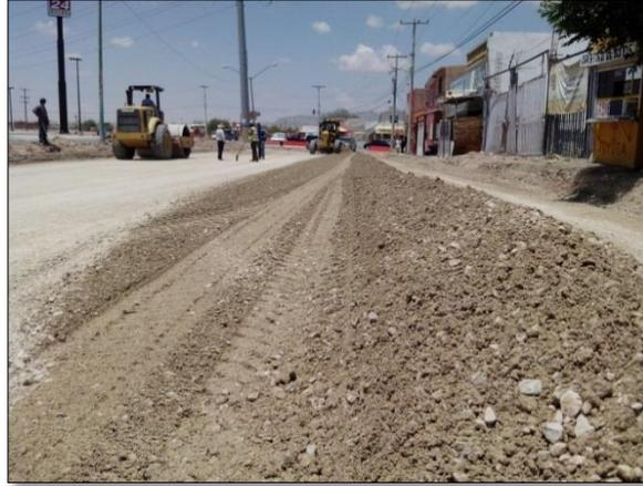
1. – JULIO: Trabajos en la terracerías del sub-tramo 1 en la av. Santiago Blancas, en la imagen se ve la colocación de base.
