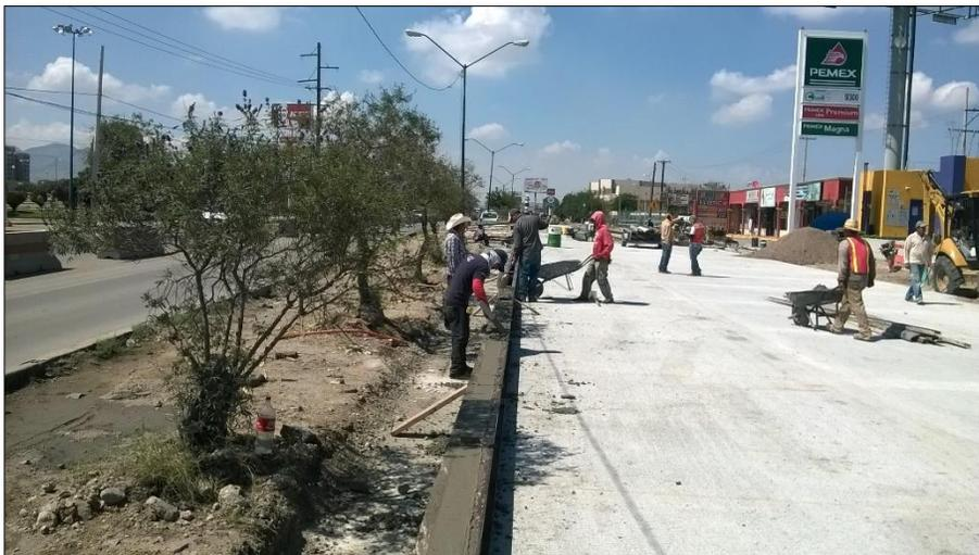
2. – construcción de losa de concreto de espesor de 28 cms, 2+694 - 2+563 del cpo. Norte.
