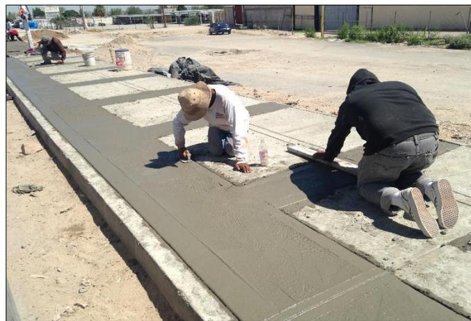
3. – SEPTIEMBRE: Construcción de firme de 10cm y 12cm de espesor (banquetas y rampas) en el cadenamiento 0+549 al 0+845
