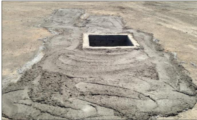
1. – JULIO: Colocación de concreto blando para rellenos de protección de pozos de visita en el cadenamiento 0+015
