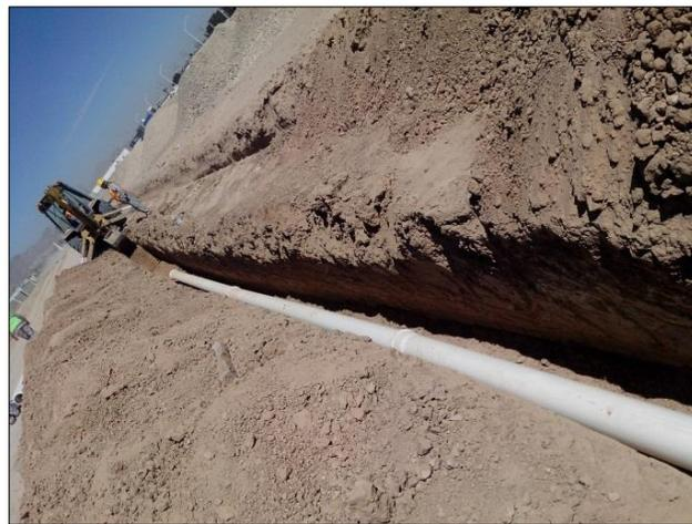
3. – Zanja para instalación de tubería de agua potable.
