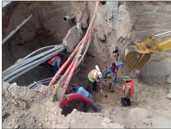
2. – AGOSTO: colocación del cableado eléctrico para el alumbrado público en el sub-tramo 5.
