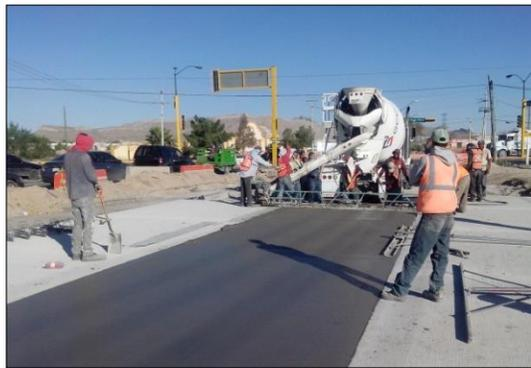
2. – AGOSTO: Con las terracerías terminadas en el cpo. Izquierdo, se realizó el colado de losas de concreto con espesor 28 cms.
