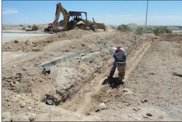
1. – JULIO: Los trabajos realizados fue la colocación de la tubería de PVC.
