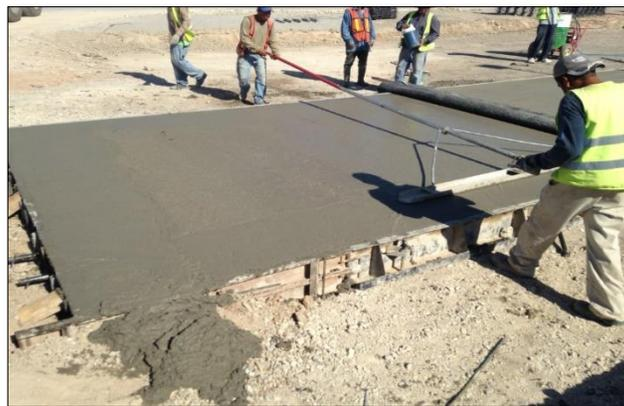
2. – AGOSTO: Se realizó el colado de losa de 28 cms de espesor en el cadenamiento 0+025 al 0+137.
