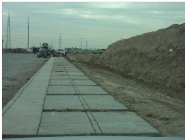
3. – SEPTIEMBRE: Construcción trabajos de imagen urbana como: construcción de guarniciones, firmes de concreto de 10 cm y las líneas guía en los firmes.
