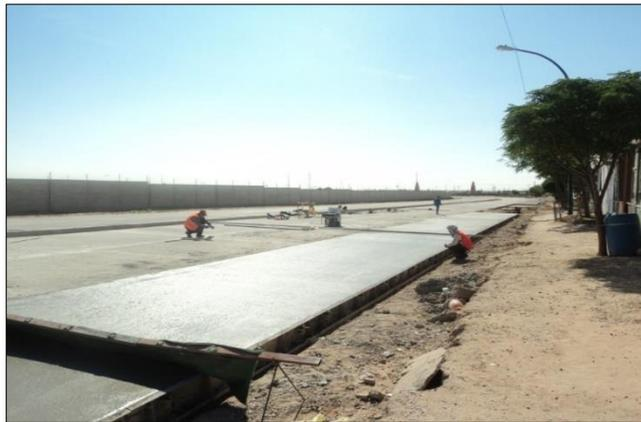
2. - AGOSTO: Colado de losa de concreto de 28 cms de espesor. Cadenamientos 0+020 – 0+101, 0+165 – 0+260, 0+386 – 0+616.
