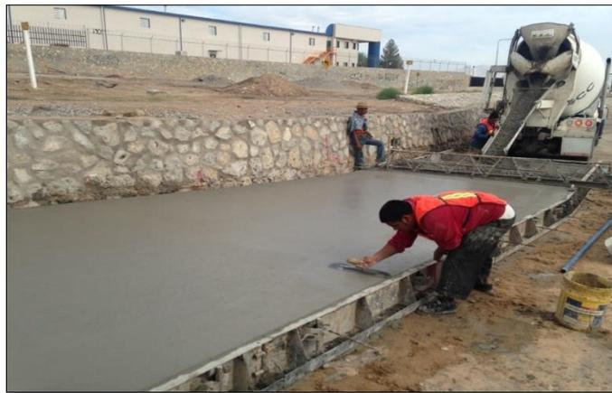
2. –AGOSTO: colado de losa de 28cm de espesor en el cadenamiento 2+005 al 2+075
