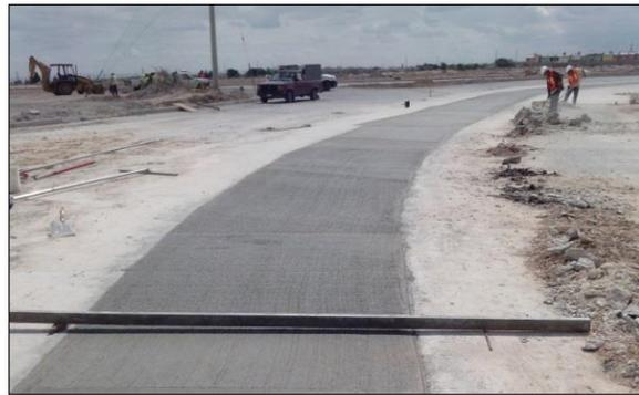
2. – AGOSTO: Se realizó únicamente la construcción de losas de concreto en la glorieta 20+160 al 20+266.50 y 20+190 al 20+180.
