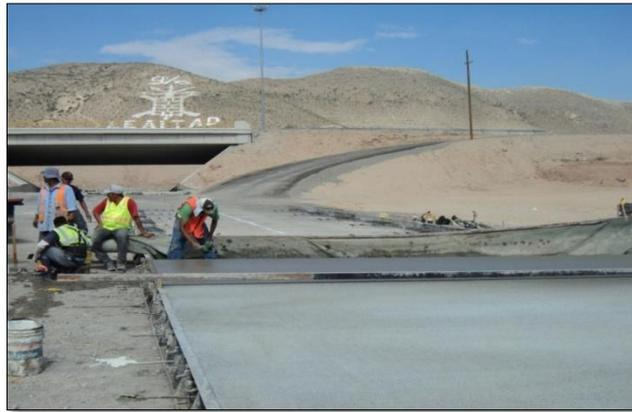
1. – JULIO: Se realizan los colados de concreto en losas de 28 cms de espesor. Cadenamientos 1+345 – 1+398.4, 1+180 – 1+273, 1+314 – 1+341.
