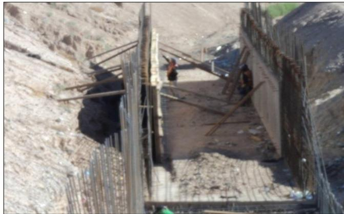
2. – AGOSTO: Construcción de muro armado de 35 cm de espesor para dren pluvial.
