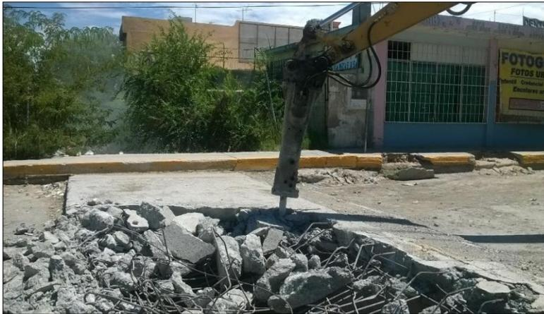
2. – AGOSTO: Retiro de losa de concreto por medios mecánicos en el cadenamiento 1+300
