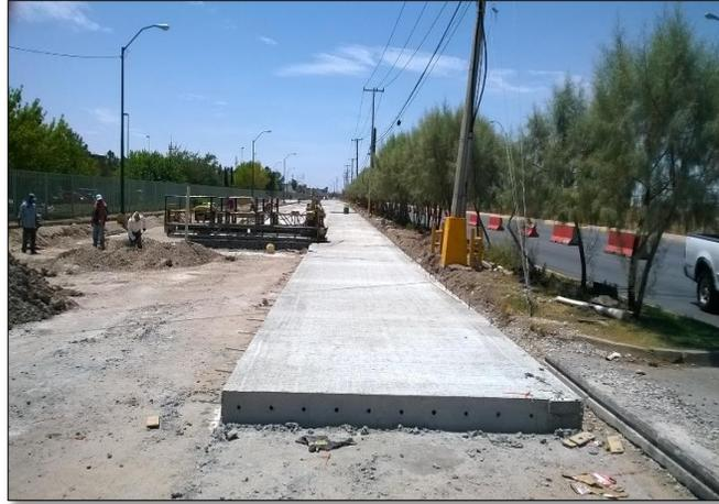
1. – JULIO: Colado de losa de concreto de 28 cms de espesor. Cad. 0+700 al 1+200.
