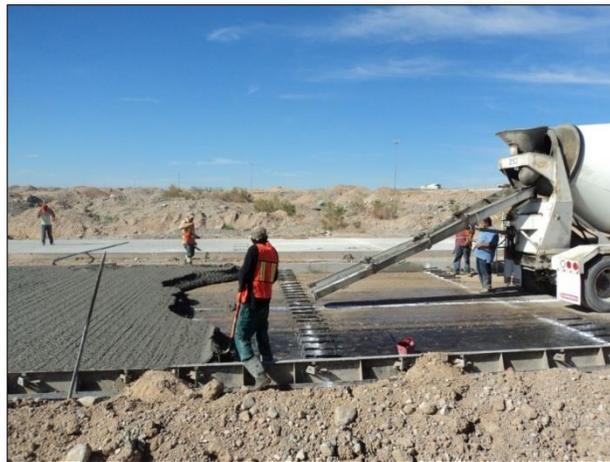
2. –AGOSTO: se continúa con la construcción de losas de concreto de 28 cms a lo largo del tramo.
