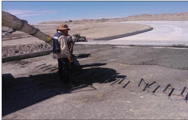
2. – AGOSTO: Se trabaja en la construcción de losas de concreto de 28 cms a lo largo del tramo.
