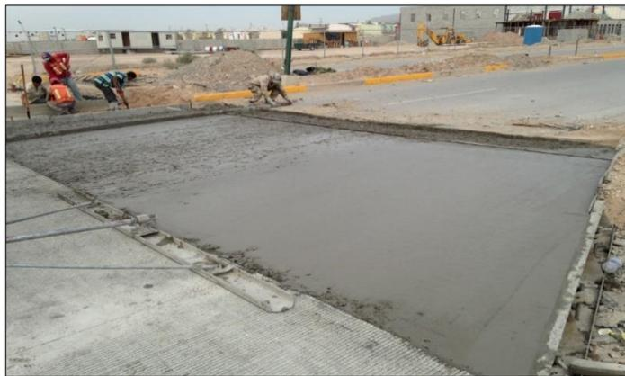
2. – AGOSTO: Durante este mes se realizaron colados de losa de 28cms de espesor en el cadenamiento 2+330 al 2+393.87.
