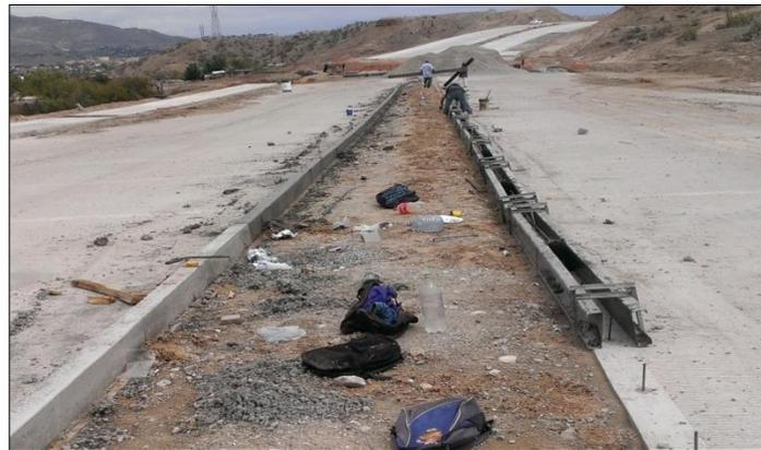
3. - SEPTIEMBRE: se realizó la construcción de la guarnición de concreto en este tramo.
