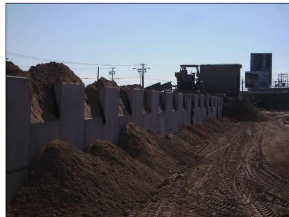
3. - SEPTIEMBRE: Demolición de muro de tierra armada. Esto por cambio de proyecto
