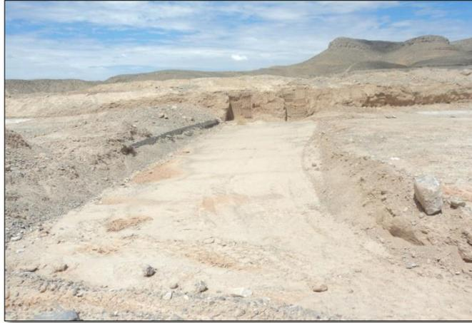
1. – JULIO: Trabajos de compactación del terreno para recibir la tubería de PVC.
