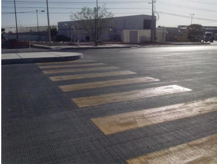
Se realizó trabajos de pintura para señalamiento horizontal: raya discontinua y continua, raya canalizadora, raya en alto y colocación de estoperoles, en ambos cuerpos.
