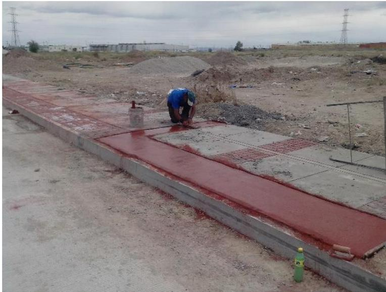
Se realizaron trabajos correspondientes a imagen urbana, construcción de firmes con acabado semi-pulido y firmes con estampado de adoquín. Cadenamiento en cuerpo derecho del 2+159 al 2+200 y cuerpo izquierdo del 0+283 al 0+252.5
