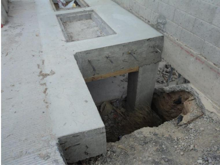
Se continua con la construcción de losa de puente en área de banquetta en de la vialidad Lucha y Triunfo y Juan Gabriel de rejillas captadoras de agua de lluvia.
