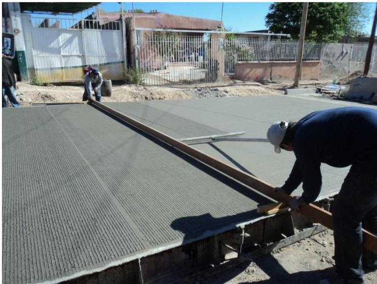
Construcción de losa de concreto hidráulico para pavimento, con ubicación en cadenamiento 0+477 al 0+401.
