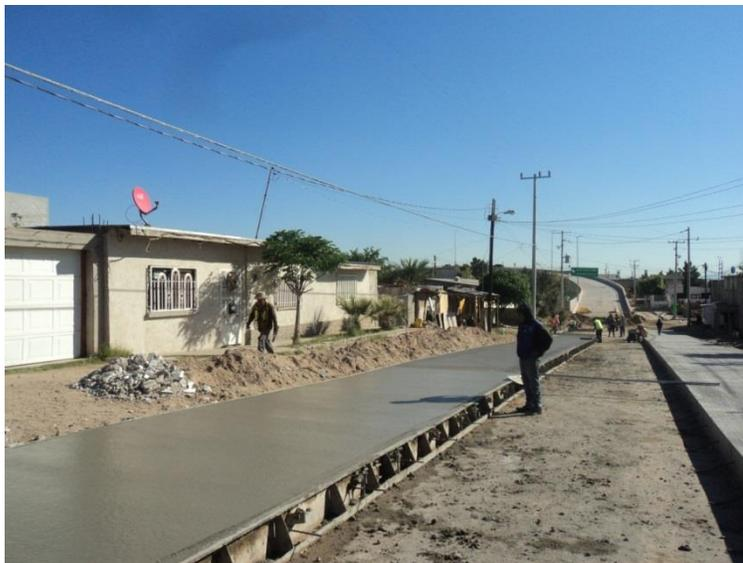
Construcción de losa de concreto con 28 cm de espesor.
