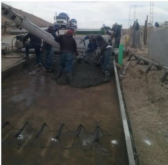
Construcción de losa de concreto del cadenamiento 0+420 al 0+540.
