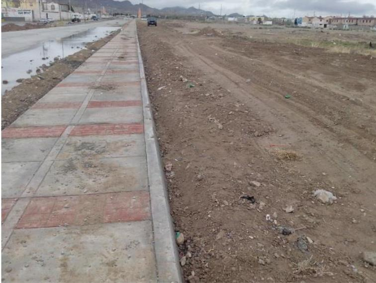
Se realizaron trabajos correspondientes a imagen urbana, construcción de firmes con acabado semi-pulido y firmes con estampado de adoquín.
