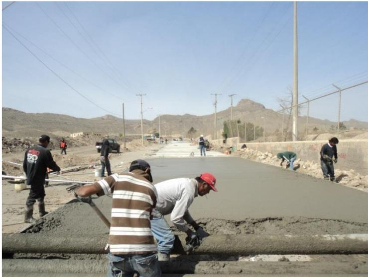
Construcción de losa de concreto hidráulico para pavimento con espesor de 28 cm, ubicado en cadenamiento 1+120 al 1+292.
