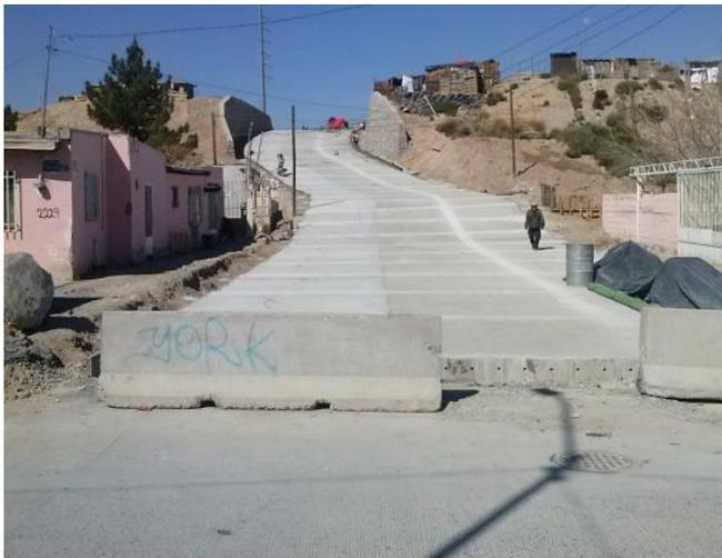
Se realizó el colado de la franja izquierda del cadenamiento 0+080 al 0+000. En la imagen se muestra las franjas derecha, central e izquierdas a la par.
