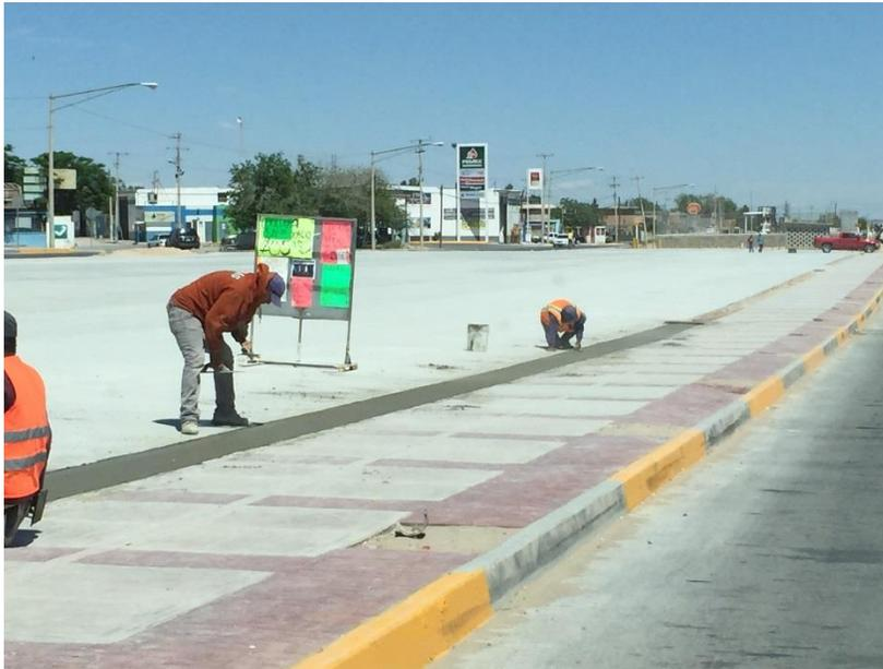
Se realizaron la construcción de firmes de concreto de 10 cms de espesor en camellón central cadenamamiento 0+200 al 0+900.
