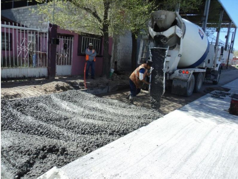
Se continua con la construcción de losa de concreto hidráulico con espesor de 28 cm.
