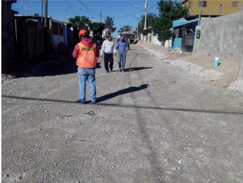
Trabajos en terracerías: corte de cajón, tratamiento de terreno natural, suministro y compactación de subrasante y base, hasta riego de impregnación en el cuerpo izquierdo del cadenamiento 0+857 al 0+720.
