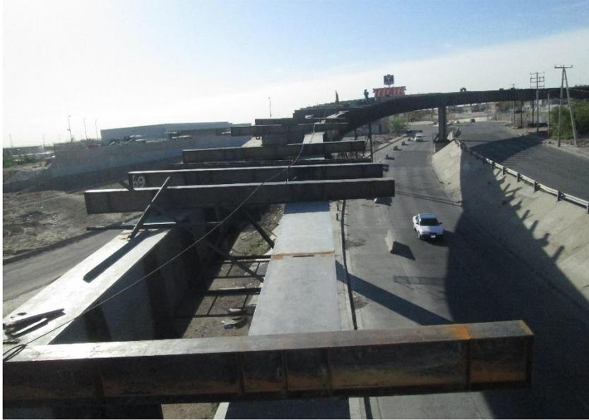
Se continúa con el suministro y montaje de estructuras de acero remachada con pernos o soldada.
