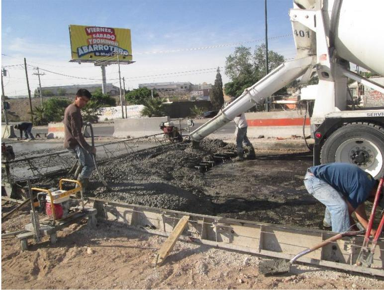
Durante este mes se realizaron colados de losa de 28cms de espesor, además de comenzar con la aplicación de pintura en traveses de acero.
