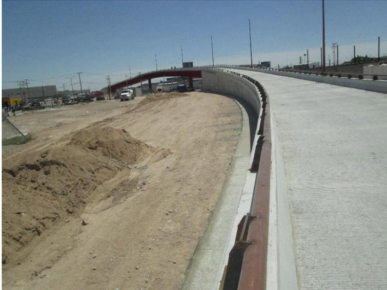
Durante este mes se realizó el suministro y colocación del parapeto metálico para calzada a lo largo de todo el puente, al igual que se dio término a la colocación de pintura del mismo.
