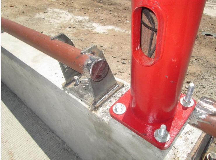
Se realizó la colocación de postes metálicos para luminaria, además de la instalación de bases y anclas de concreto. Se trabajó en las instalaciones eléctricas.
