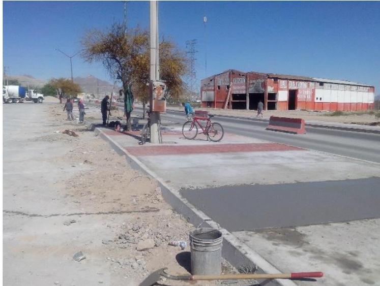
Se llevaron a cabo trabajos correspondientes a imagen urbana: construcción de firmes con acabado semi-pulido, firmes estampados con acabo de adoquín, en camellón y rampas vehiculares. Cadenamiento del 0+122 al 0+266.
