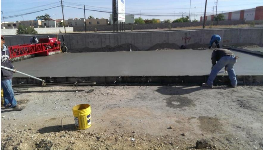
Colocacion de losa de rodamiento de espesor de 28 cm ubicada en el cadenamamiento 1+254 al 1+250.
