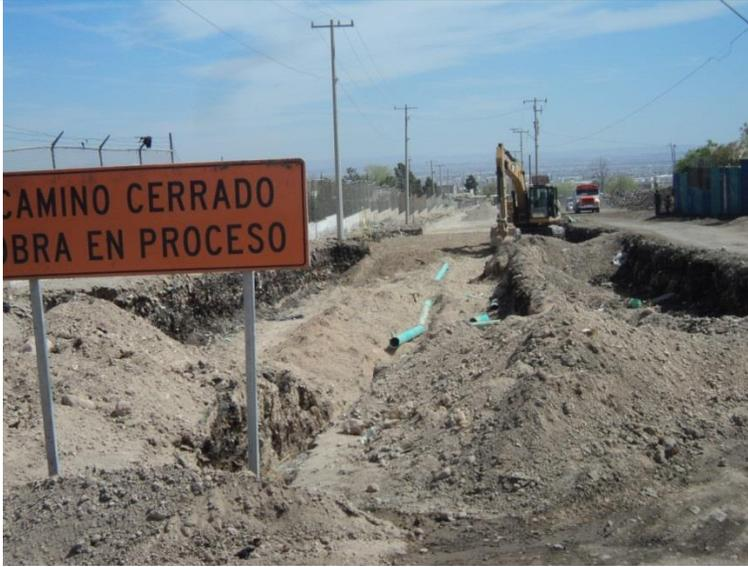
Junta Municipal de Agua y Saneamiento continua cambiando tuberías de agua y drenaje.
