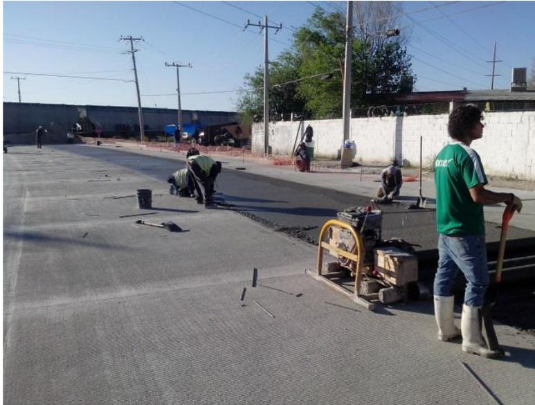
Construcción de losa de concreto de 28 cms de espesor en franja izquierda y derecha del cuerpo izquierdo de la vialidad.
