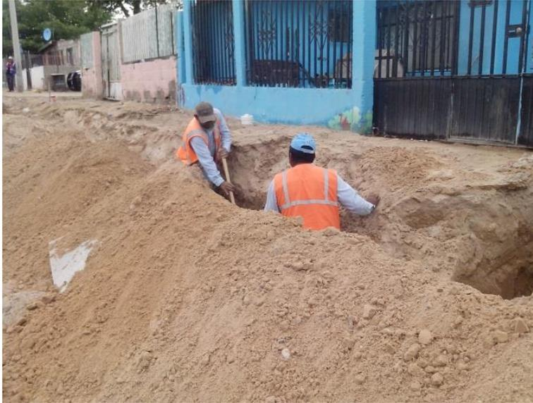
Se inician trabajos por parte de las prestadoras de servicios (JMAS Y GNJ): tomas y descargas y colocación de tuberías en cpo. Izquierdo 0+860 al 0+580 y cpo. Derecho del 0+875 al 0+985
