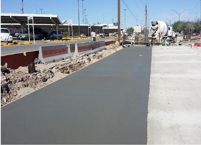
Losa de concreto recién colada en carril derecho cadenamiento del 0+906 al 1+052.
