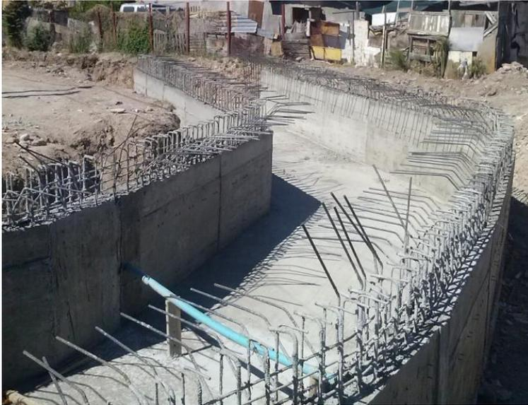
Se terminó con la construcción del ducto alcantarilla del cadenamiento 0+00 a 0+85.57.
