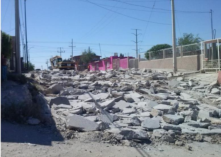
Durante este mes se inician los trabajos de demolición de losa de concreto y banqueta existentes en el tramo.
