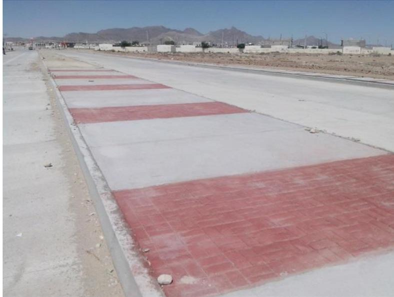
Durante el completo se llevaron a cabo trabajos de imagen urbana y construcción de guarniciones en el cuerpo derecho en ambos lados y camellón.
