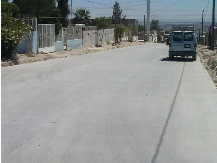
Durante este mes se realizó únicamente colado de losa de 28cm de espesor en el cadenamiento 4+60 al 5+64.70
