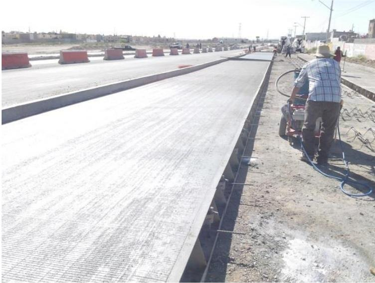
Construcción de losa de concreto de 28 cms de espesor en franja izquierda, central y derecha del cuerpo izquierdo de la vialidad.
