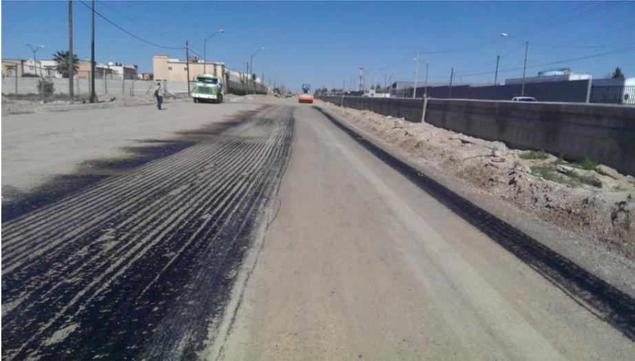
Riego de impregnación con emulsión asfáltica ubicado en el cadenamiento 1+240 al 1+080.
