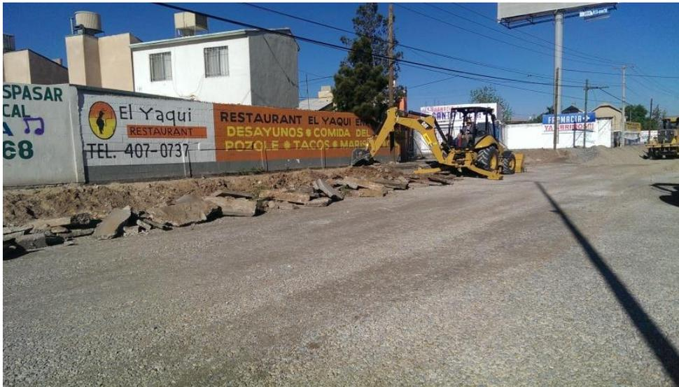
Demolición y retiro de banqueta existente de 10 cm ubicada en KM 0+703 al 0+650.
