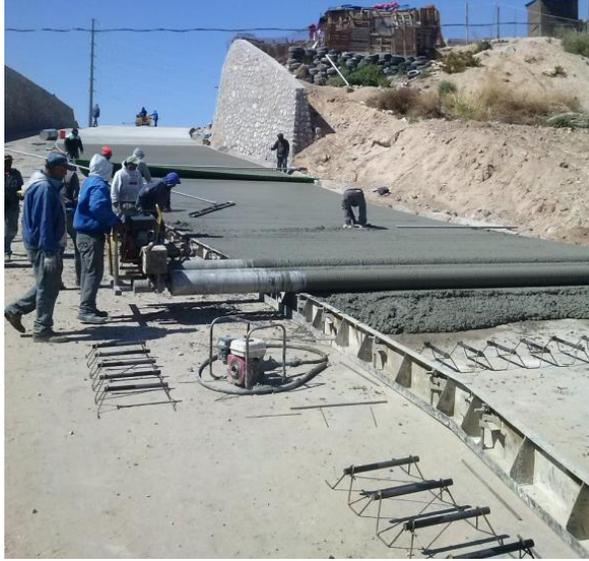
Construcción de losa de concreto de 28 cms de espesor del cadenamiento 0+080 al 0+000 de la franja central y derecha.
