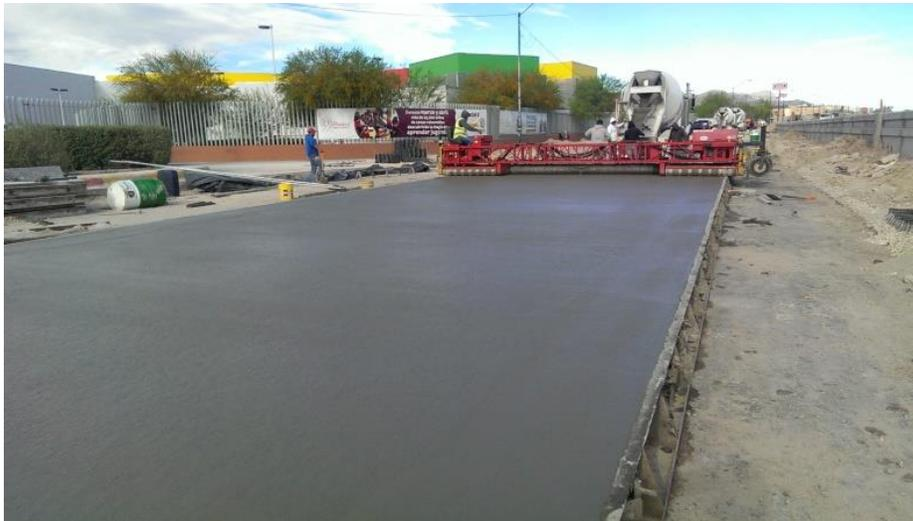
Colocación de losa de rodamiento de 28 cm de espesor, ubicado en el cadenamiento 1+564 al 1+515.
