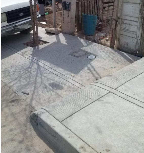
Construcción de firme de 12 cms de espesor en cocheras de viviendas.
