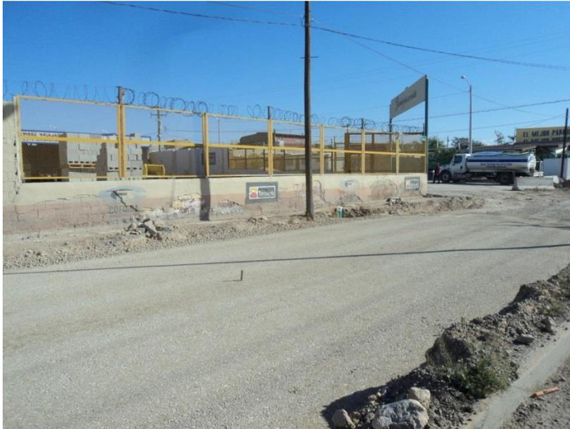
Formación de la base hidráulica de 15 cm de espesor, ubicada en el cadenamiento 1+023 al 0+510.
