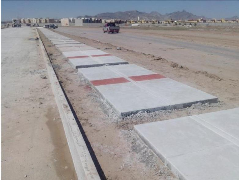
Durante el completo se llevaron a cabo trabajos de imagen urbana y construcción de guarniciones en el cuerpo izquierdo en ambos lados, cadenamiento del 1+950 al 2+148 lado derecho y del lado izquierdo 2+146 al 2+134.
