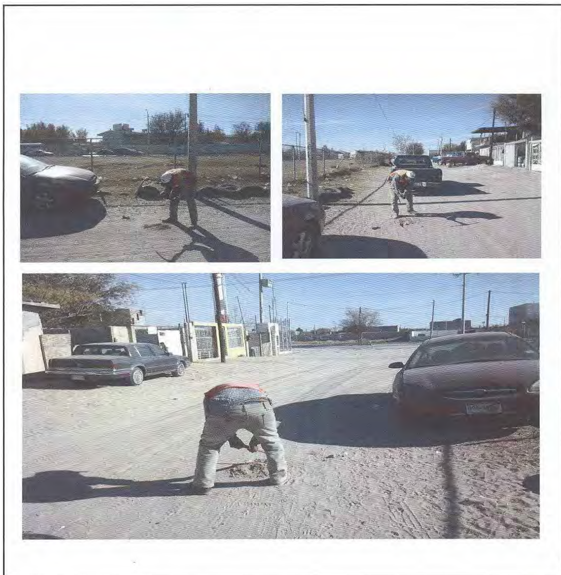
Graficas 1, 2, 3. Vista de obra op-172-2013, donde se muestra: estudio de mecánica de suelo.
