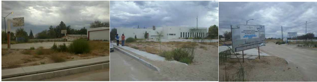
Graficas 1, 2, 3. Vista de obra op-156-2013, donde se muestra el terreno a construir en el poblado de San Agustín, cancha multideportiva
