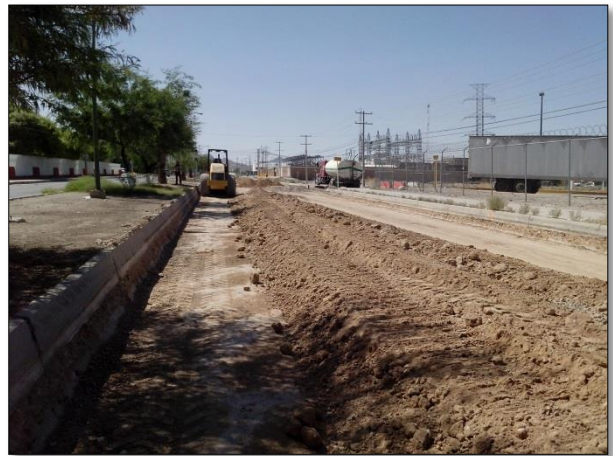
2. – Corte de cajón con una profundidad de 73 cms.
