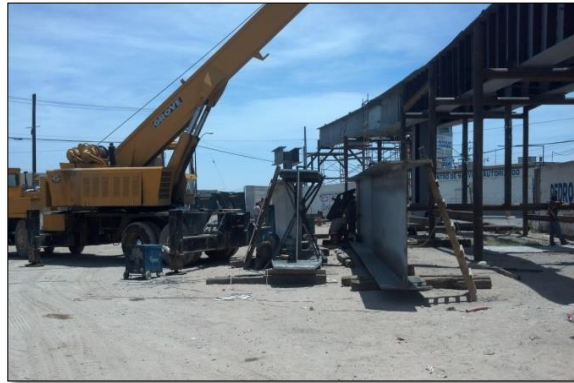
2. - MAYO: Colocación de traveses.
