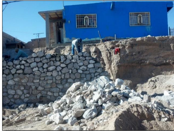
1. - ABRIL: Construcción del muro de mampostería del lado poniente de la calle P. Giner Duran.
