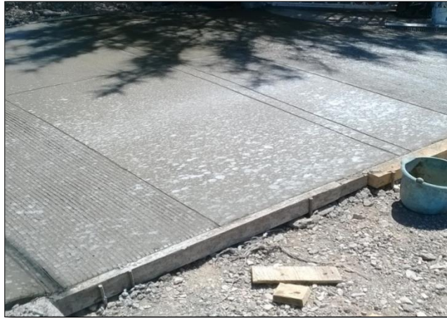
2. – MAYO: Trabajos correspondientes a imagen urbana: construcciones de guarniciones y firmes de espesor de 12 cm.
