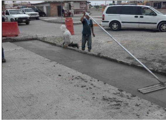
1. - ABRIL: Construcción de losa de concreto para empatar con el Eje Vial Juan Gabriel.
