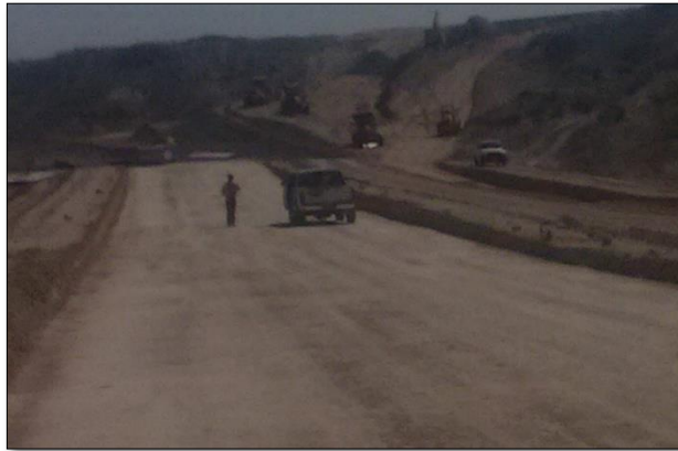
1. - ABRIL: Formación de terraplenes y liberación de las terrecerías.
