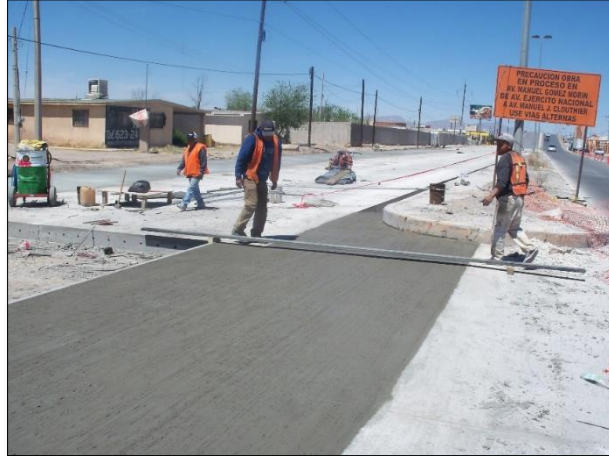
1. - ABRIL: Construcción de losa de rodamiento en 0+224 al 0+376
