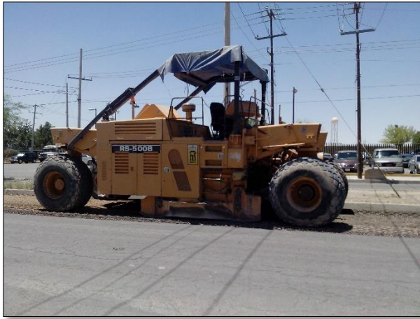
1. – Trabajos de fresadora, para retiro de carpeta asfáltica.
