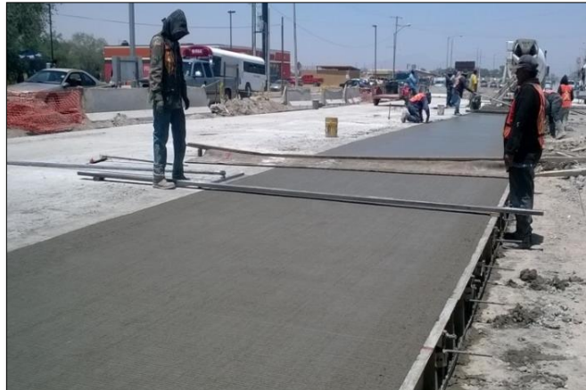
2. - MAYO: Construcción de la superficie de rodamiento del 1+100 al 1+140
