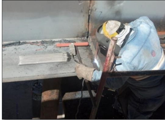
1. - ABRIL: Unión por medio de soldadura.
