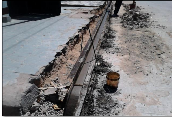
1. – ABRIL: Trabajos correspondientes a imagen urbana: construcción de firmes de 10 cms, guarniciones y suministro de concreto estampado.
