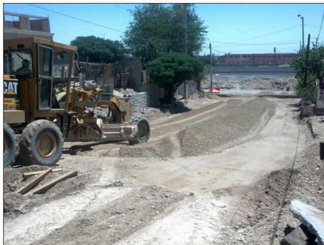
3. - JUNIO: Suministro de base y riego de impregnación.
