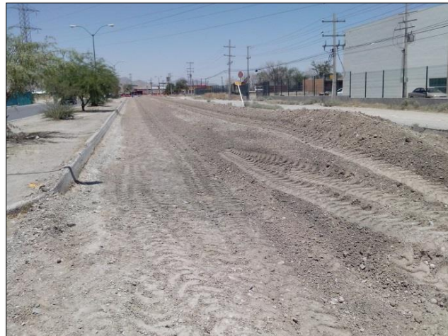
3. – Material acamellonado producto del corte.
