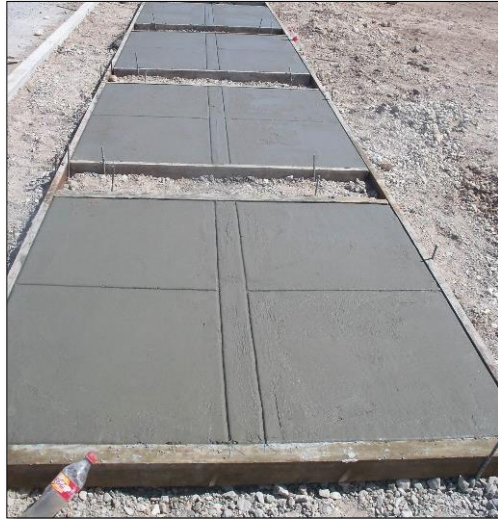
1. - ABRIL: Trabajos de imagen urbana
