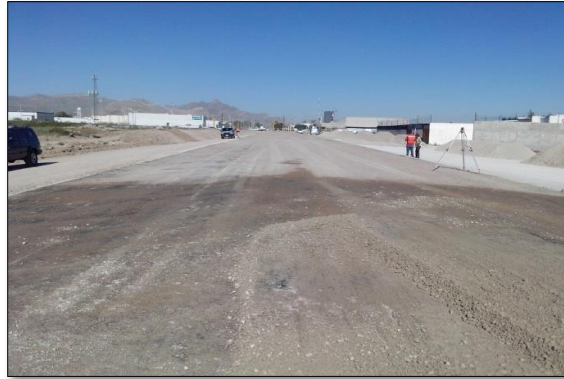
1. – OCTUBRE. Base terminada del cadenamiento 0+040 al 0+900.
