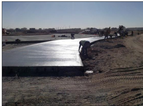
3. – DICIEMBRE. Construcción de losa de espesor 28 cm.
