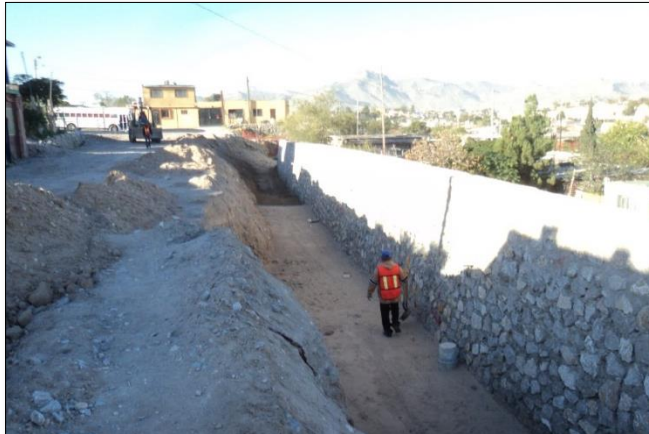
2. – NOVIEMBRE: Construcción de muro de mampostería.
