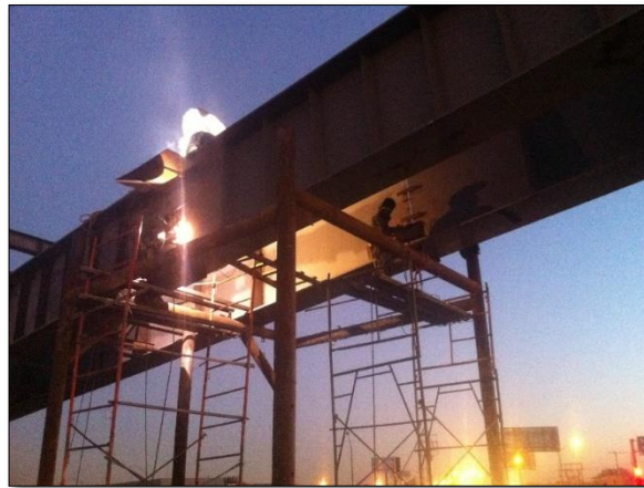
2. – NOVIEMBRE: Unión de traves 1 y 3 por medio de soldadura.
