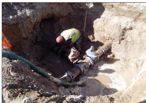
3. – DICIEMBRE. Trabajos correspondientes a la JMAS, como el cambio de válvulas.
