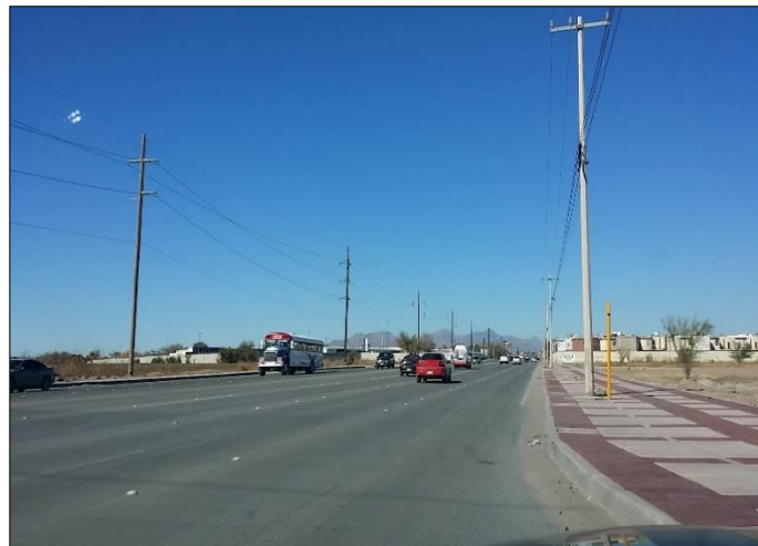
3. – DICIEMBRE: Este es el estado actual de la vialidad.
