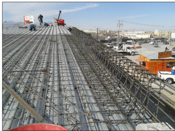
3. – DICIEMBRE: Armado de acero para de losa y parapetos.
