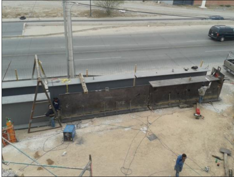
1.- DICIEMBRE: Fabricación de traves principales para el tramo 1 del puente.
