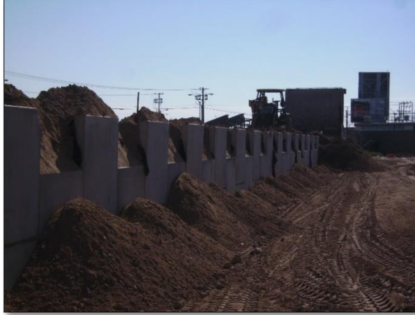
1. – OCTUBRE: Demolición de muro por cambio en el proyecto
