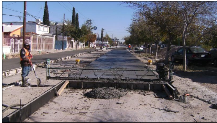
2.- NOVIEMBRE: Se realizaron colados del cadenamamiento 0+400 al 0+250 del cpo. Nte.
