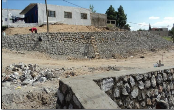
1. – OCTUBRE: Construcción de muro de mampostería.
