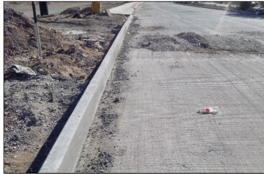
2. – NOVIEMBRE. Construcción de guarnición de concreto de 12 cm.
