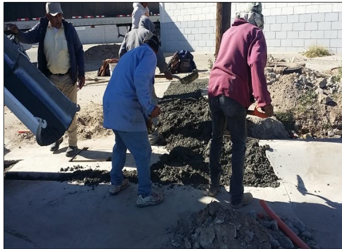
2. – NOVIEMBRE: Trabajos en banquetas con detalles.
