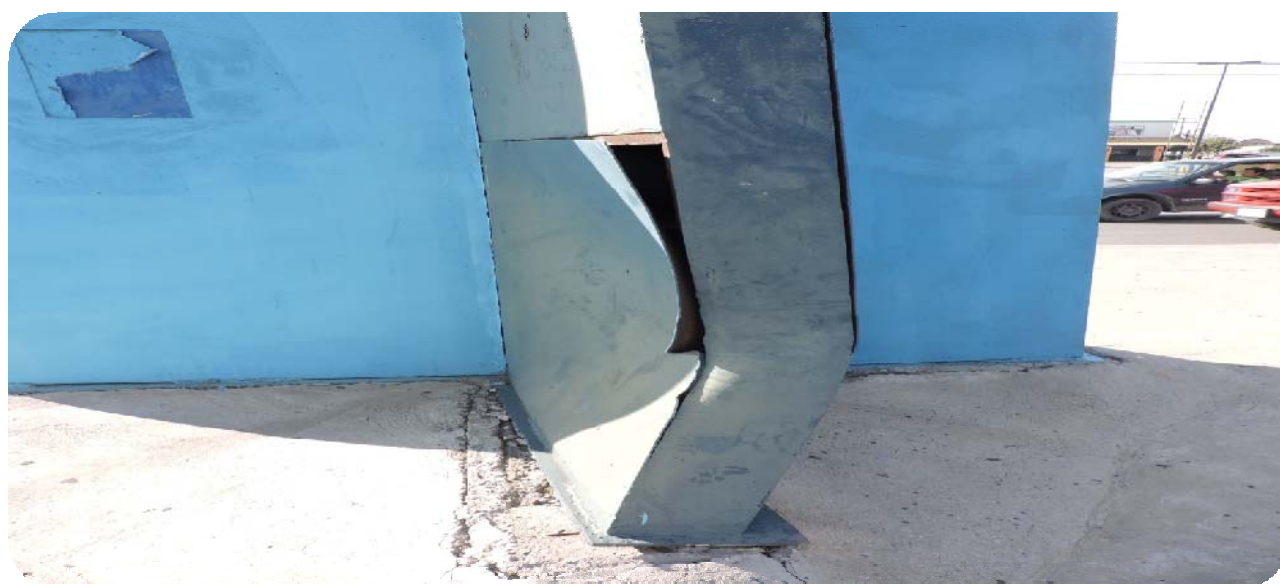
17. Palma Real Escultura dañada, lámina doblada por aparente choque No tiene placa
