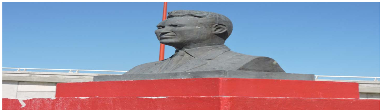
7. Busto a Teófilo Borunda Falta pintura y limpieza
