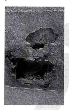
✓ Una de las bardas del patio se aprecia no fue debidamente cimentada por lo que la misma corre el riesgo de colapsarse.
