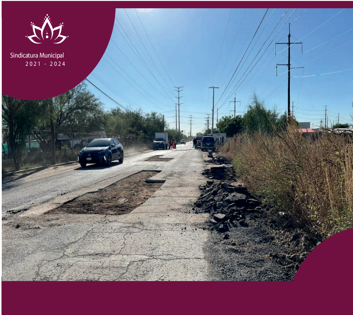
Foto 1 Av. San Bernardo, 25 de octubre 2022, se puede observar como no se realizó el tratamiento adecuado en la base o sub-base del bache, ni tampoco se niveló previo a la colocación de la mezcla ni posteriormente, asimismo, se observó que dejaron residuos de materiales de base para pavimento y de escombros producto de las demoliciones de pavimento depositados en los camellones, banquetas y vías circunvecinas.
