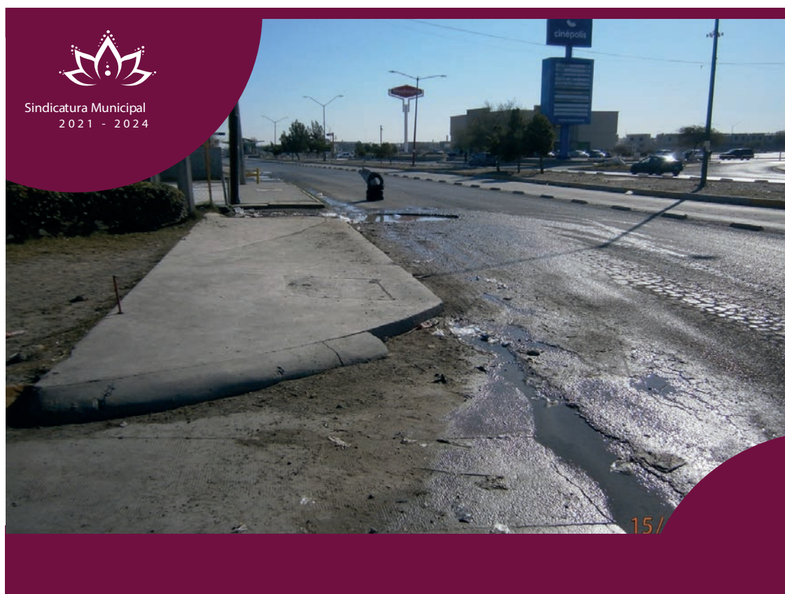
Foto 9, Boulevard Zaragoza, 15 de diciembre de 2022, se puede observar que, pese a la reciente ejecución de los trabajos de bacheo el pasado 24 de octubre de 2022, la mala aplicación y baja calidad de la mezcla, traen como consecuente el rápido deterioro de los trabajos propiciando la reaparición de baches.
