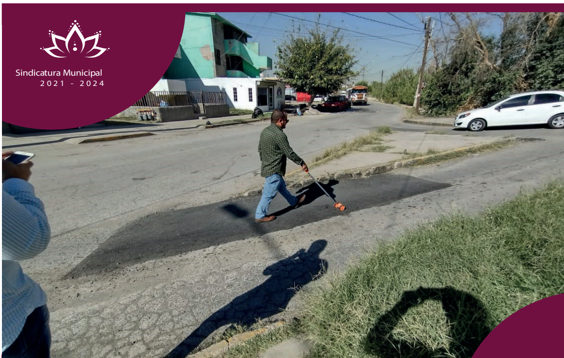
Foto 4. Calle Búfalo, 08 de noviembre 2022, se puede apreciar el trabajo de bacheo realizado, a su vez, se aprecia un hundimiento considerable, a causa de que no se preparó la base, previamente a la colocación de la mezcla.
